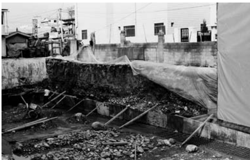
대전동 강우빌딩 공사
