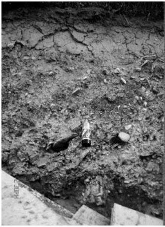
보령시청 청사 공사
