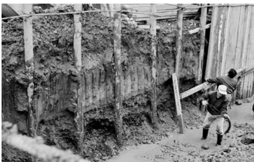
구시청 아파트 공사
